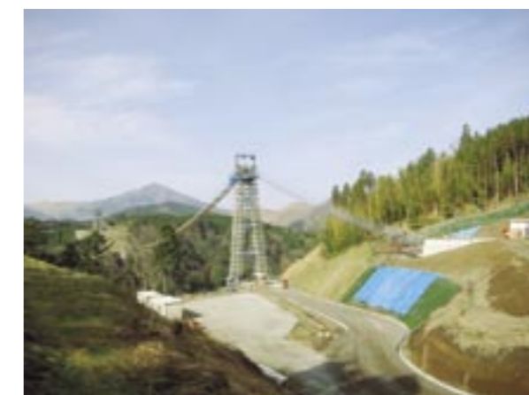
ケーブル施工時写真
