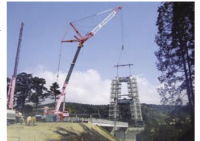
主塔施工時写真
