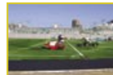
10月中旬の工事中の風景
