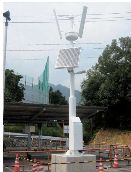
マイクロ風車と併設された太陽光パネル
